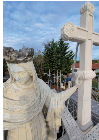
Un des chantiers de l'entreprise. / DDM.
